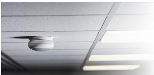
O nosso escritório tem sensores de movimento por áreas que permite desligar automaticamente as luzes, depois de alguns minutos de inatividade. Temos também interruptores para autonomamente desligar luzes, sendo assim mais eficientes que os sensores, e não estando dependentes dos mesmos.
